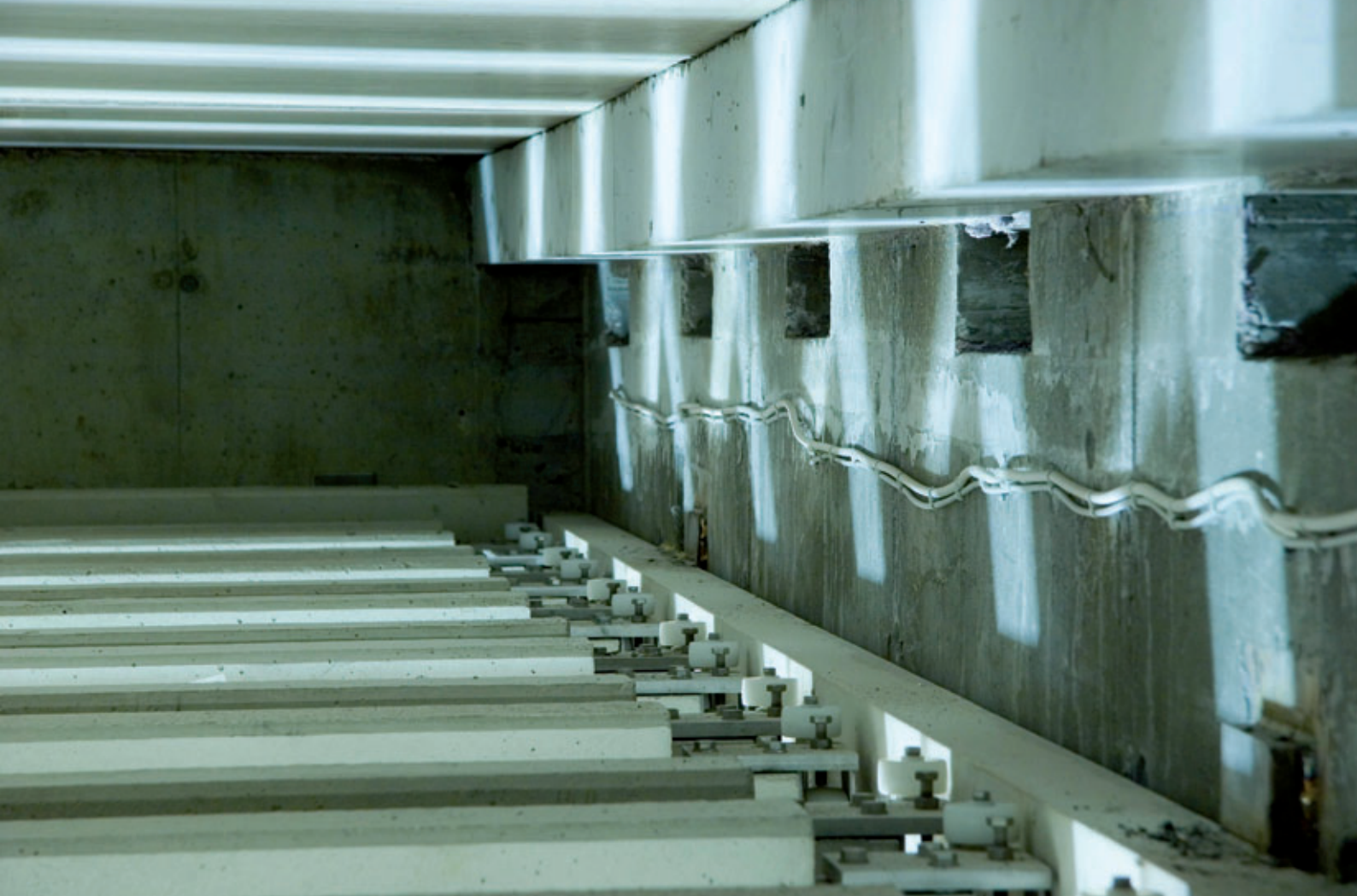
Zwischenraum rollende Unterdecke und tragende Geschossdecke
