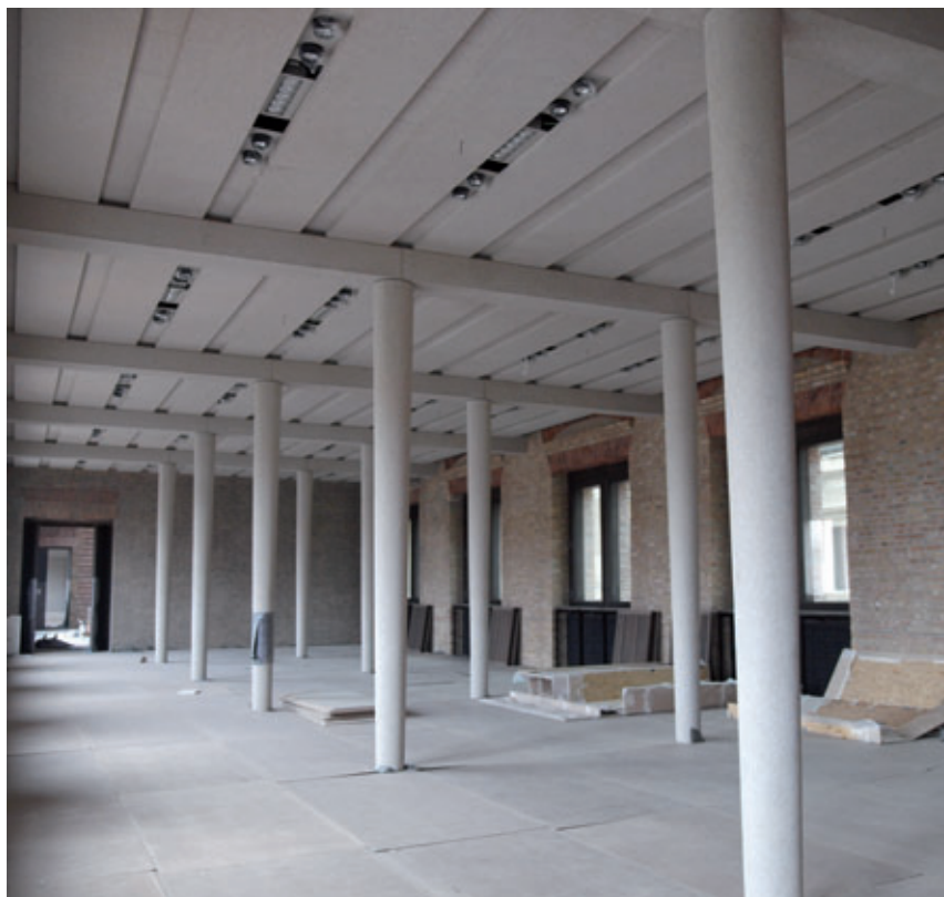
Fertige Rolldecke mit eingebauten Beleuchtungskörpern und „Karottenstützen“
