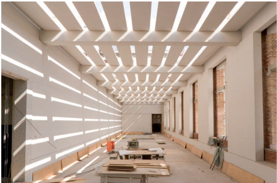
Roldecke im Montagezustand ohne Oberdecke mit noch geöffneten Zwischenräumen
