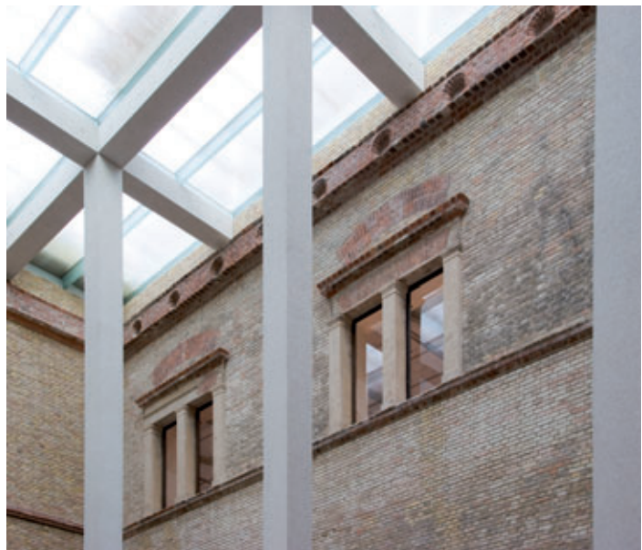
Fertigteilstützen mit Balkenrost in der Glasdachebene des Ägyptischen Hofes
