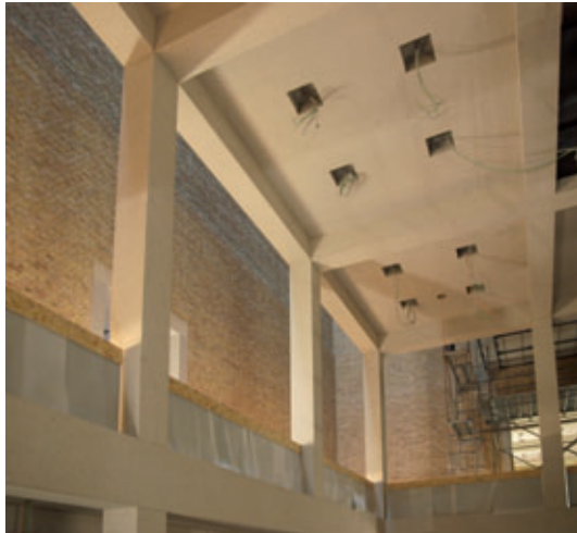
Untersicht der Fertigteilplattform im Ägyptischen Hof
