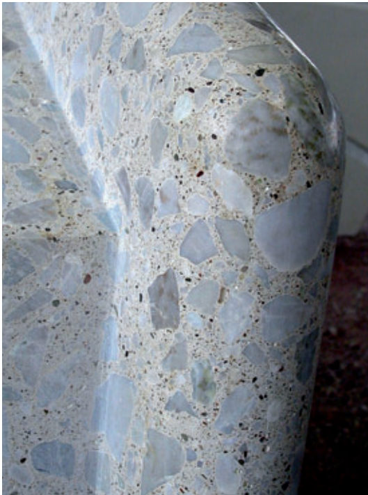
Detail des geschliffenen Handlaufs
