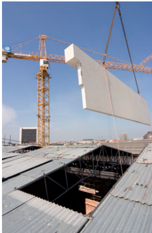
Einheben eines Fertigteiles durch das geöffnete temporäre Schutzdach
