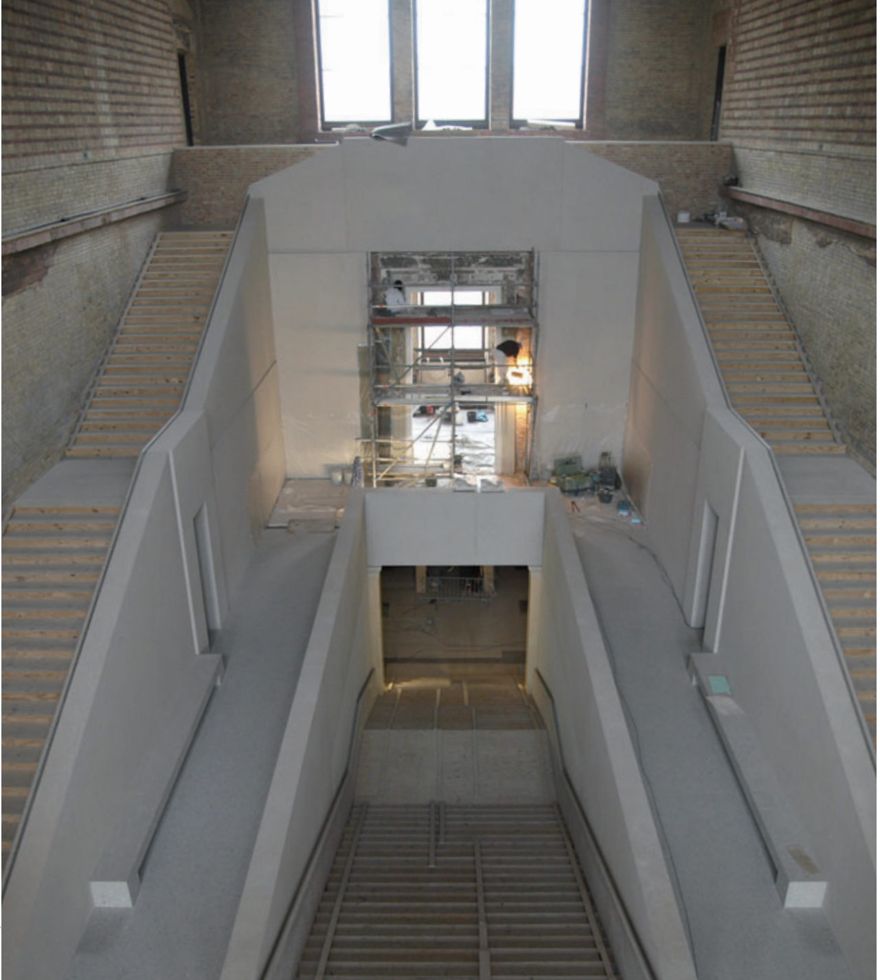
Haupttreppenhaus mit neuer Treppenanlage aus hochwertigem Architekturbeton
