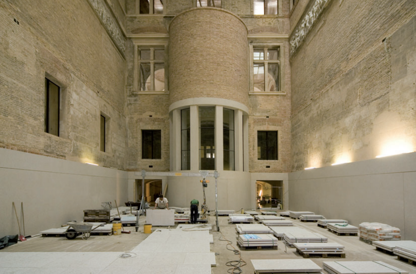
Verlegen der Bodenplatten im Griechischen Hof mit seiner markanten Apsis
