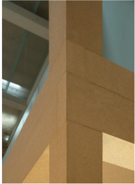
Eckknotenpunkt der Fertigteilkonstruktion im Ägyptischen Hof
